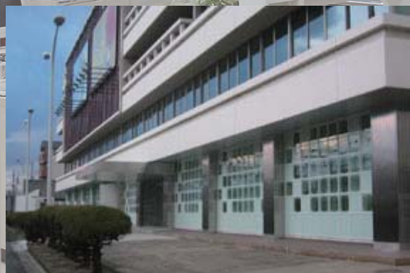
タキイ種苗京都ビル(京都駅前) / ガラスと鋼格子による耐震改修
