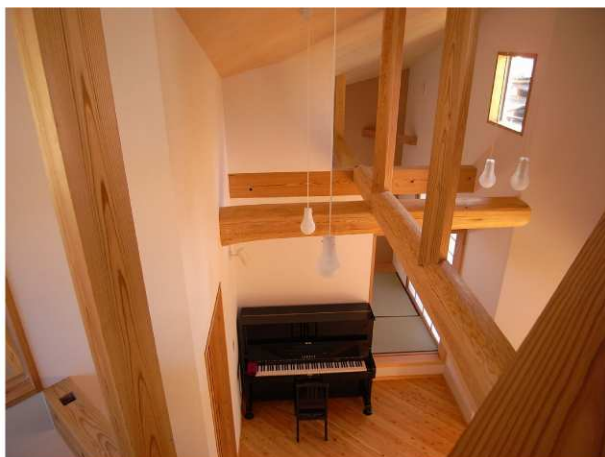
吹抜けホールに十字の杉丸太梁
