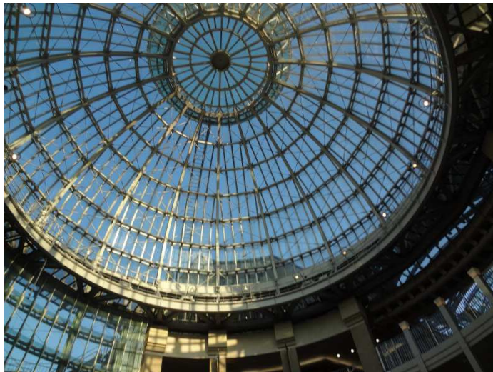
高松市商店街アーケードガラリア
