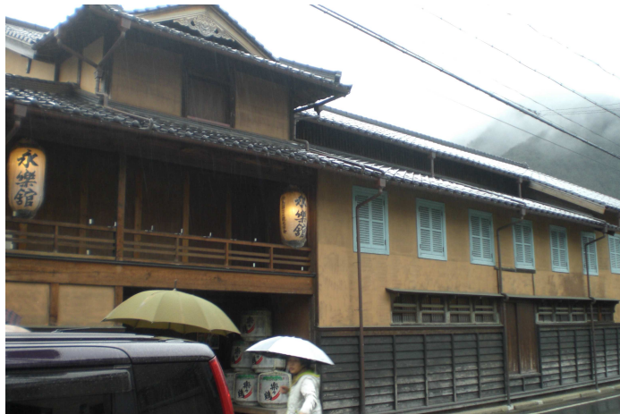
(永楽館外観 旧弘道小学校の水色の鍔戸)
