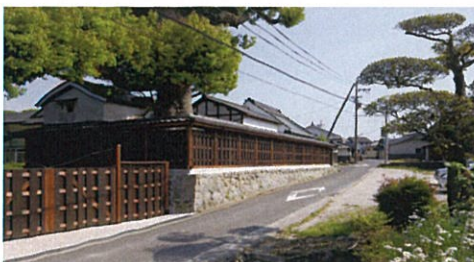
・審査委員長賞 御所の古民家（減築・改修） ・所在地 御所市名柄
