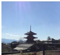
法起寺三重塔
