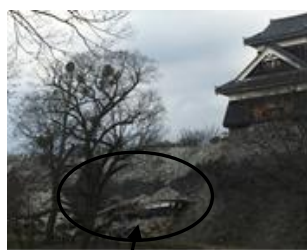
石垣と共に崩落した櫓
