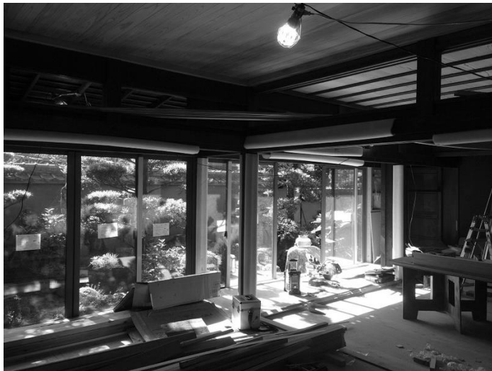
〔住宅の改修現場〕
