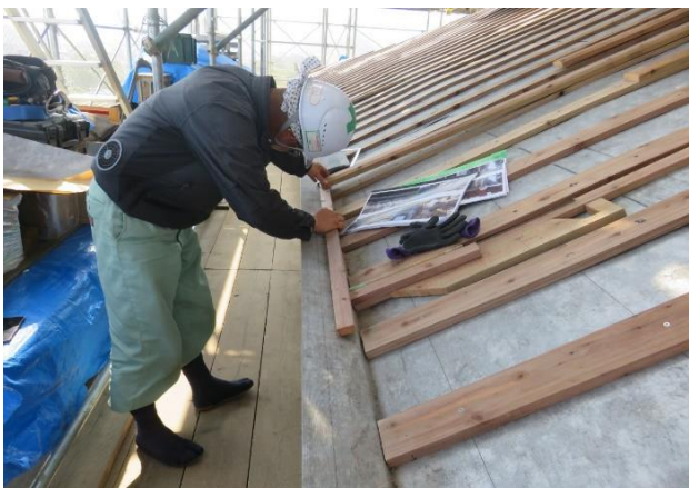
瓦の割付作業
