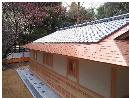
某公共施設 (トイレ)
