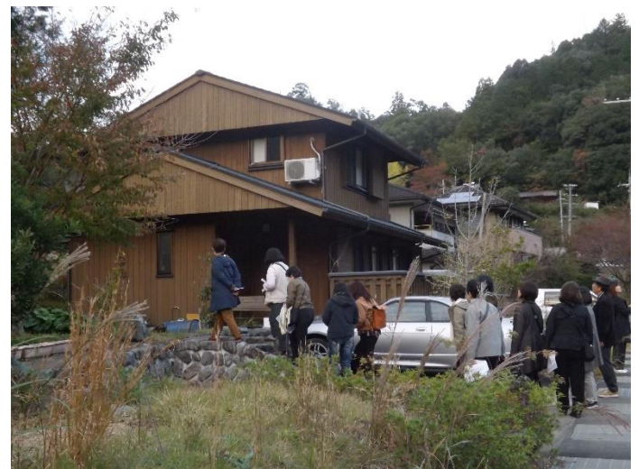
木造公営復興住宅（高森地区）
