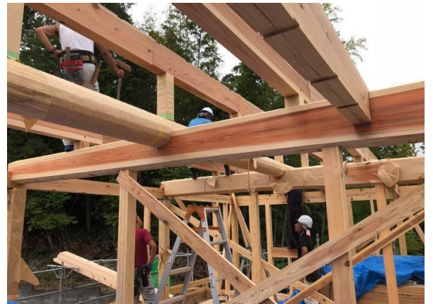
新築の現場 棟上げ
