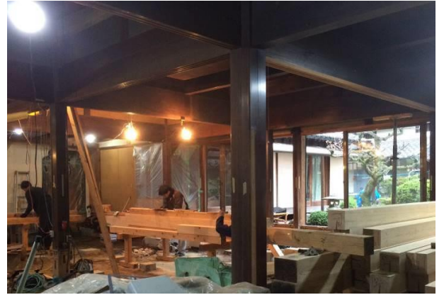
古民家改修の現場
