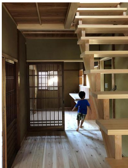
スケルトン階段のある玄関ホール
