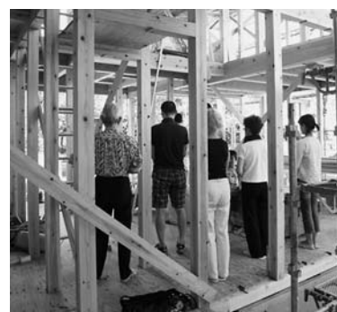
県産材でつくる奈良をつなぐ木の家 上棟式の様子
