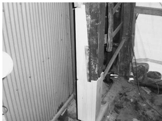
柱の修理例（金輪継ぎ）
