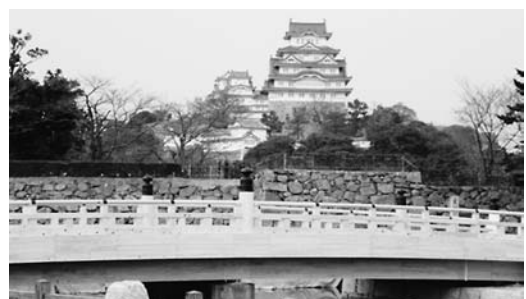
図9 木橋の欄干に使われたDMDHEUヒノキ材
