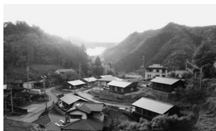
十津川村猿飼集落の完成した復興公営住宅
