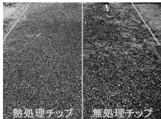
図7 試験施工した木チップ舗装(6年経過)
