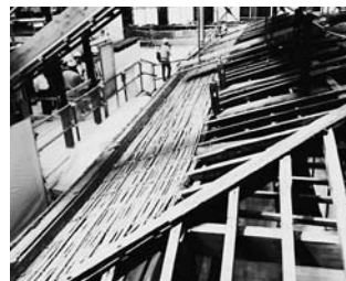
軒先部分の葺土・割竹下地
