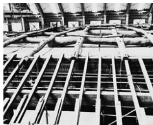
小屋裏の梁組・垂木組
