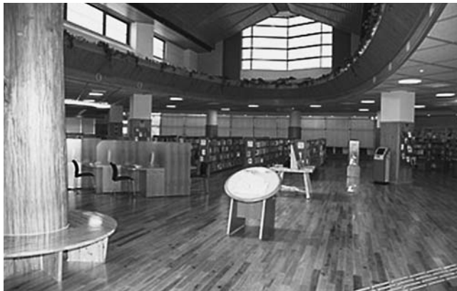
図3 ヒノキ圧密床材の施工例（マイウッド・ツーHP）
