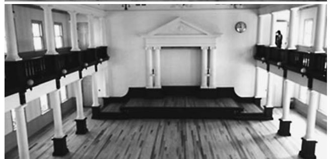
図5 吉野杉ハードフローリングの施工例 （上）橿原公苑内ジョギング＆サイクリングセンター （下）愛媛大学付属中学講堂（有形登録文化財）
