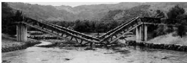
図1 落下したボンゴシ橋（森林総合研究所HPより）
