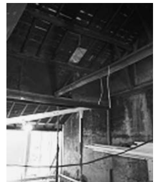
工事の中庭側の小屋裏と軒桁の高さ (記・檀原支部 米田 巧)
