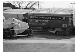
現場内のPCa工場
