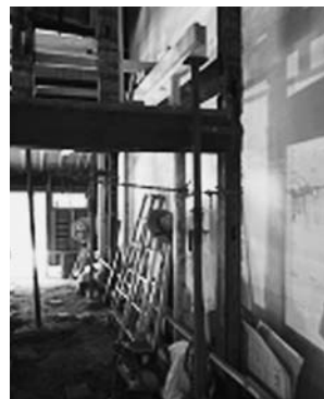
工事中の構造体の様子
