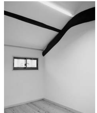
修理後2階の様子
