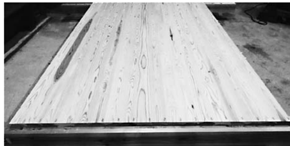
図6 木ダボと木ねじを用いた厚板耐力床
