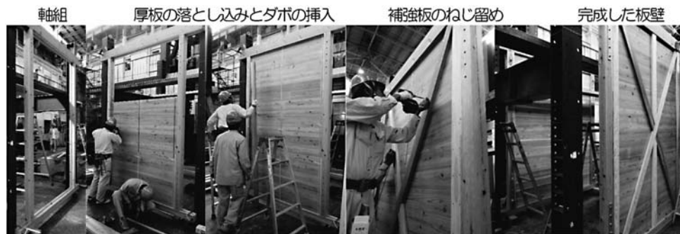
図5 新構法のスギ厚板耐力壁の組み立て作業
