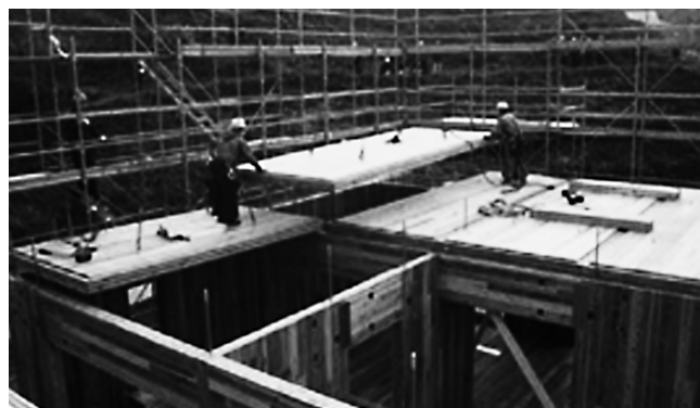
図2 CLT建築物の組み立て
