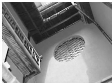
松田家住宅 坪庭吹抜け
