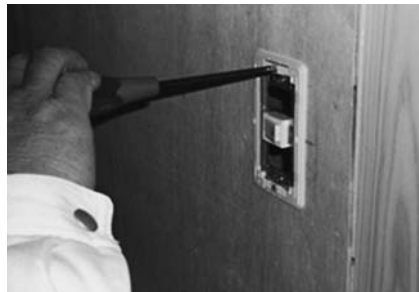
電気工事実習
