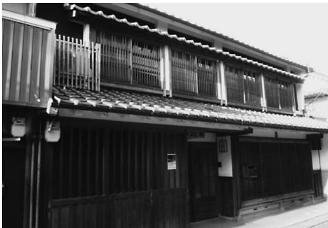
空き家をコワーキング・スペースに改修
