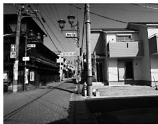
柳4丁目の状況 町家が解体され分譲住 宅が建設された 平成29年10月撮影
