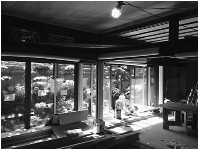
〔住宅の改修現場〕
