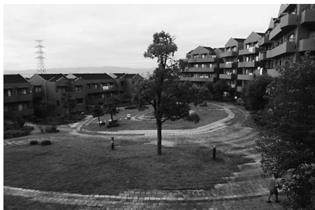
写真4. 中庭を囲む住棟配置。中庭の領域性と自然的監視性を高めている。(大阪府交野市)
