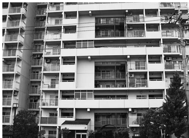
写真3. 15階建のマンションの最上階の廊下から、外部から侵入した男に小3男児が投げ落とされる事件が発生。住棟入口にオートロックシステムはなく、住棟内部に死角が多い。(2006年、川崎市多摩区)
