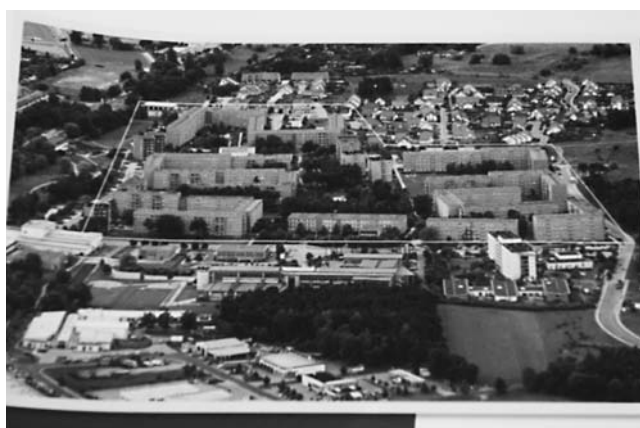
写真2 撤去前の住宅団地
