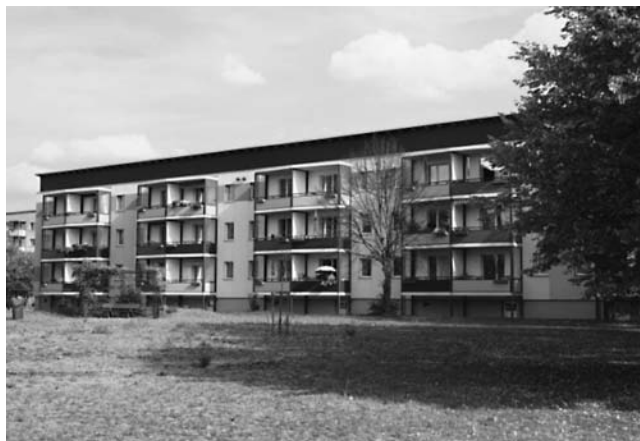
写真1 減築した住宅（5階建て住宅の4階、5階部分を撤去し、3階建てに変更した例。ドイツザクセン州ヴァイスヴァッサー市郊外）
