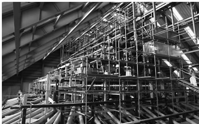
写真3 建設途中で実施した振動計測の様子
