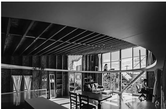
写真2 〈天井の構図〉 自立的なオブジェクトとして働く構図の穴の空いた天井を挿入する改修 (撮影: 新建築社)
