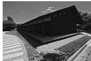
写1：明日香庭球場クラブハウス （流通木材による公共建築事例）
