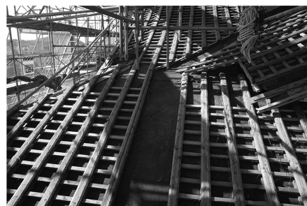
熊本城 施工状況
