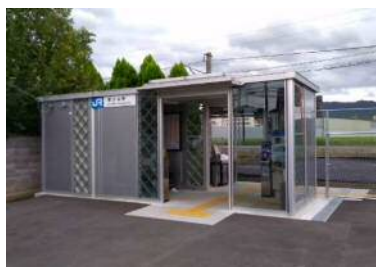
駅舎の事例 (香久山駅舎)
