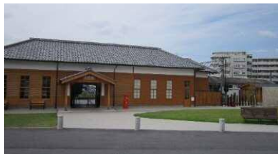
京終駅舎 外観
