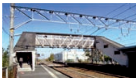
跨線橋（古レールを利用して作られている）
