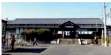
櫛本駅舎 外観
