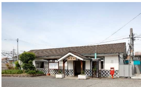
柳本駅舎 外観
