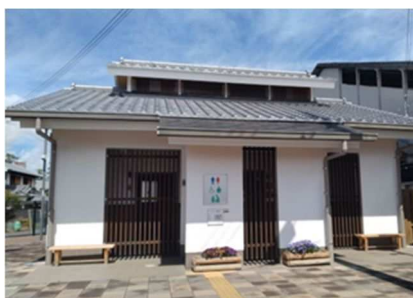
新設されたトイレ
